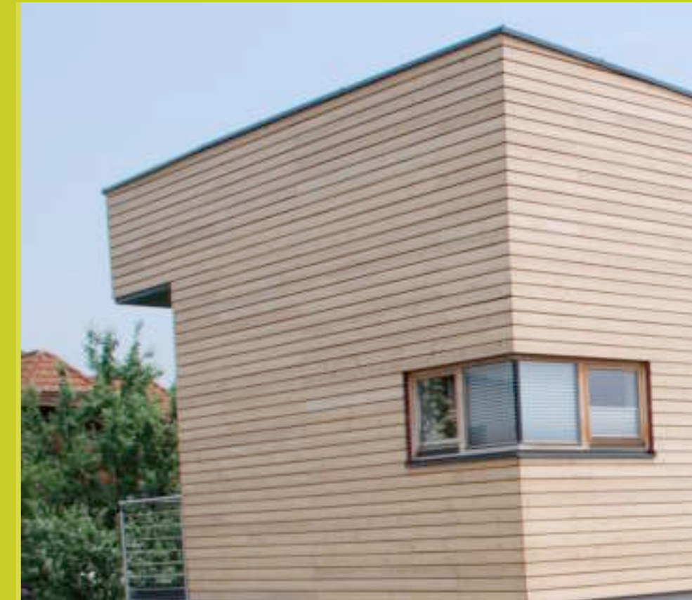
Stützenfreiheit bei Eckausbildungen, offener Giebelanschnitt bei sämtlichen Gebäudekanten
