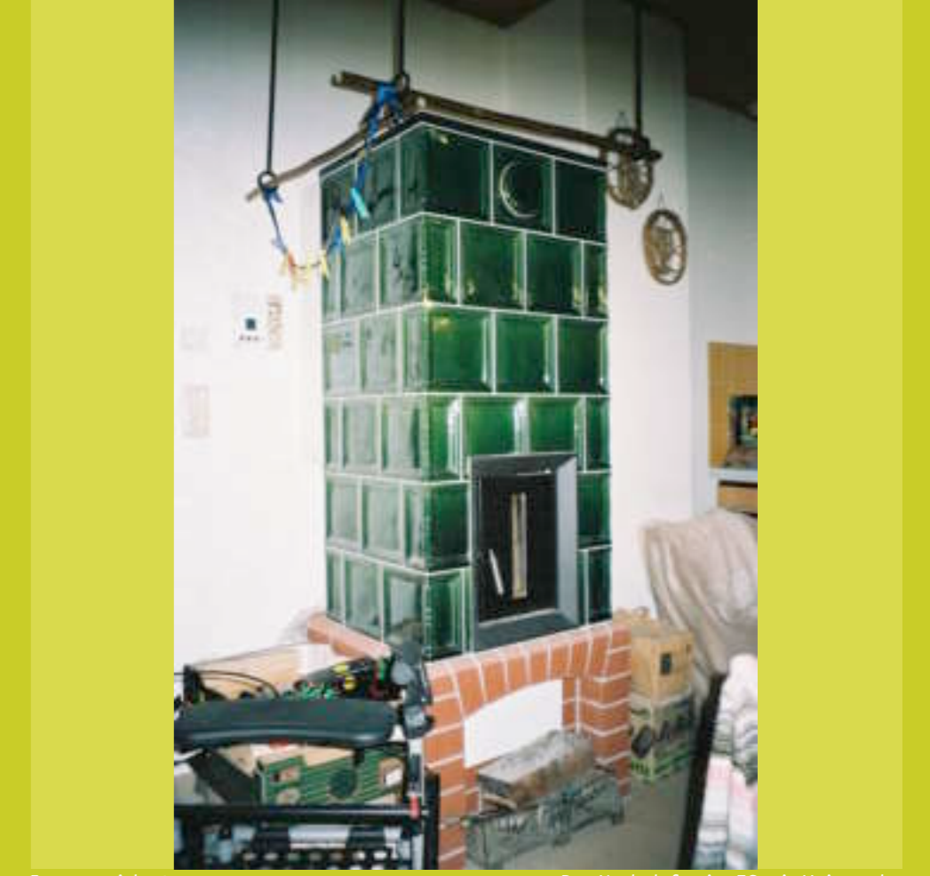
Innenansicht 2 Der Kachelofen im EG mit Heiztasche
