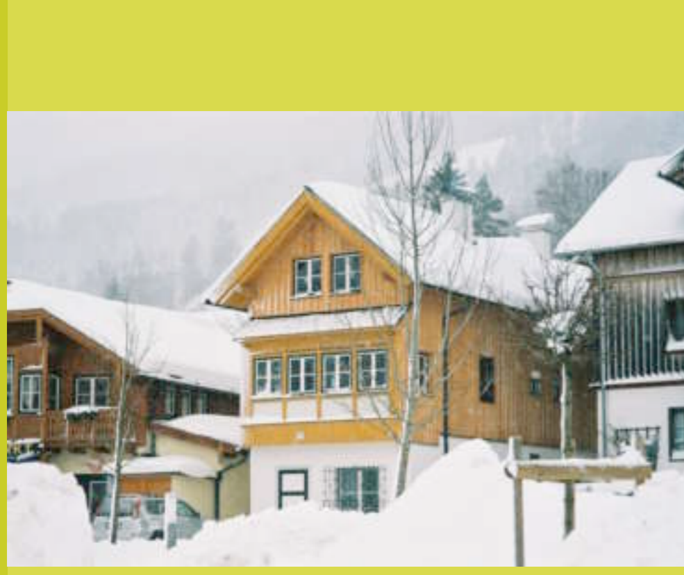
Gesamtansicht 1 Ansicht von Südosten, die Photovoltaik am Vordach kann man erahnen
