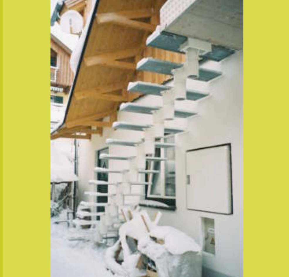
Die Außenstiege (Geländer kommt Ende Februar) – sogar der Zählerkastendeckel ist gedämmt
