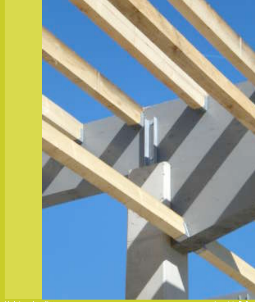
Anschluss Dachbinder/Stütze
