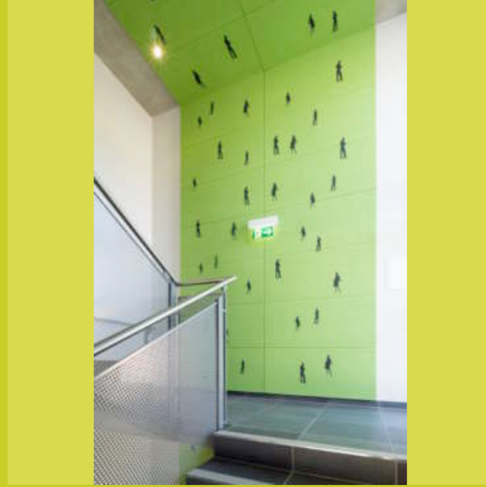
Innenansicht 2 Stiegenhaus mit Herakustikwand
