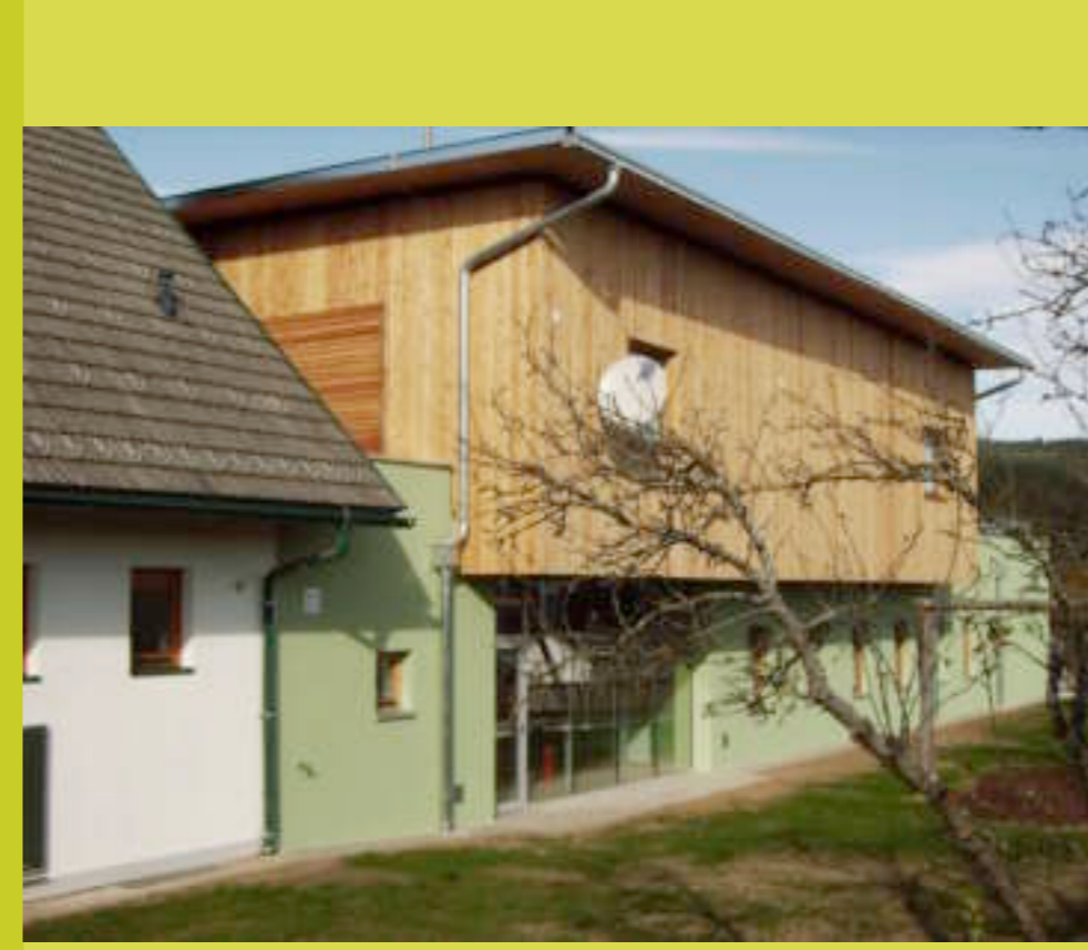
Gesamtansicht 3 von Südosten
