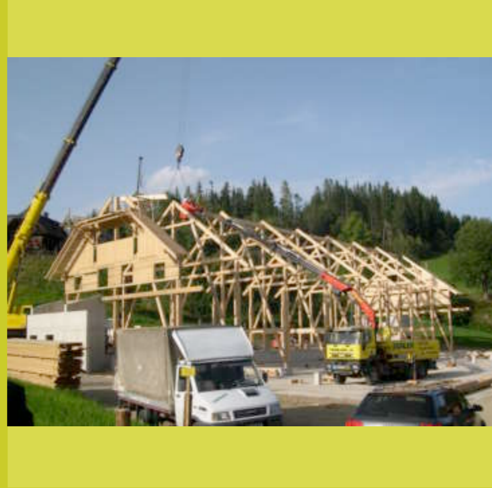
Gesamtansicht 2 Montage Konstruktion Hauptgebäude
